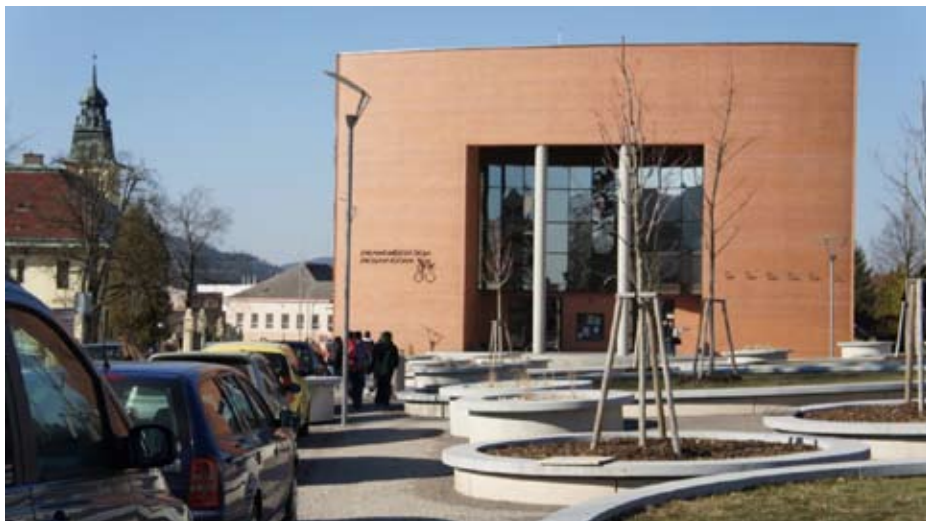
Předprostoru základní školy by prospěla redukce počtu betonových kruhů a naopak doplnění mobiliáře.
