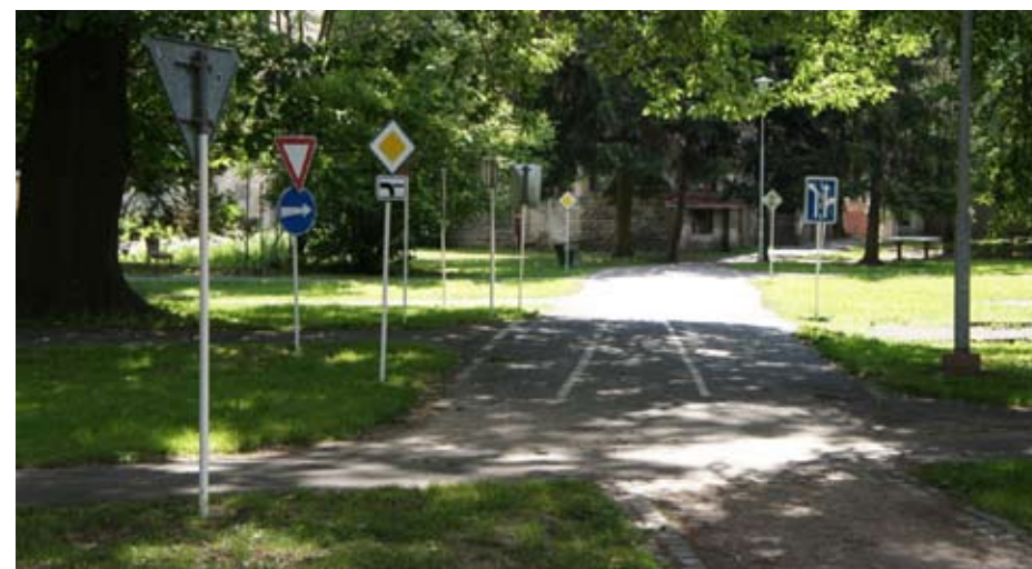
Dopravní hřiště s poškozeným povrchem cest.
