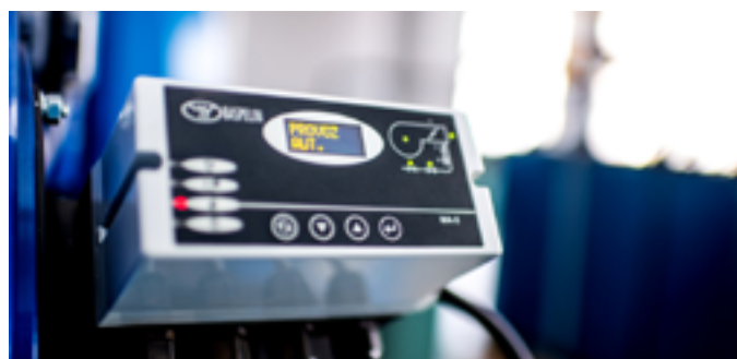
modernizace kotelen Ústí nad Orlicí
