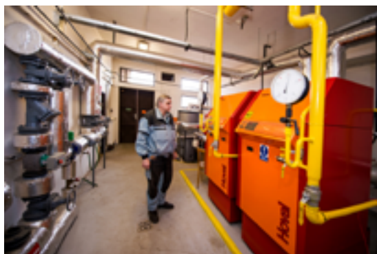
modernizace kotelen Ústí nad Orlicí
