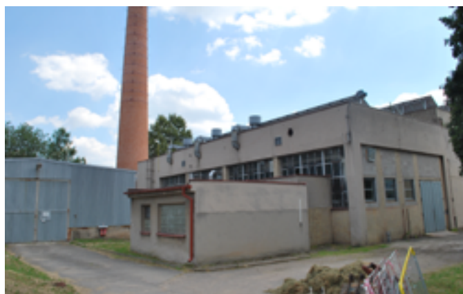
kotelny v Ústí nad Orlicí
