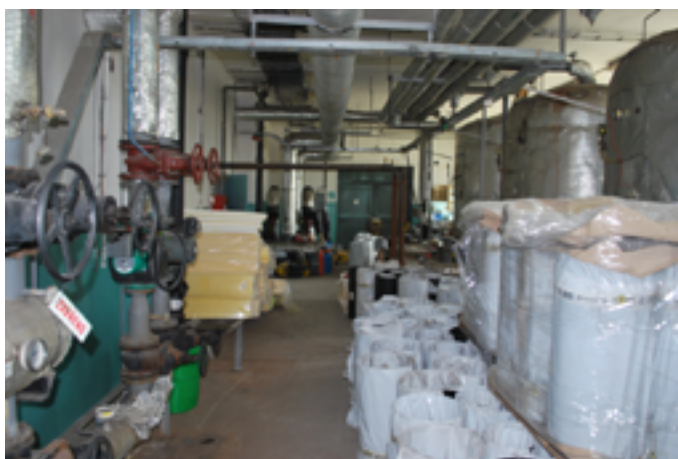
kotelna Podměstí v rekonstrukci 2013
