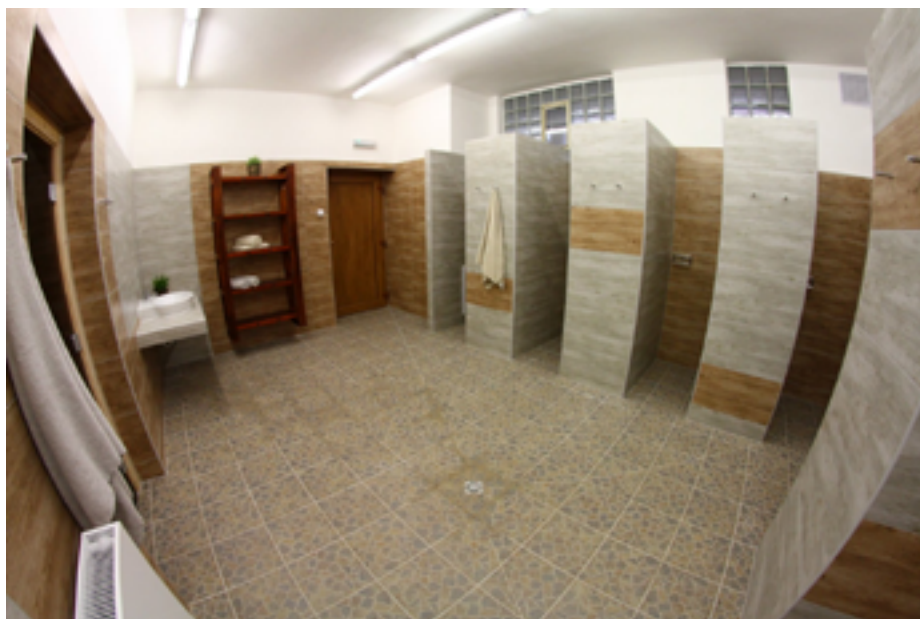
Sauna 2013 sprchy po rekonstrukci
