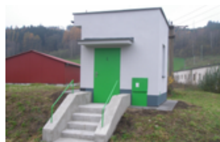
po rekonstrukci objekt nad UO
