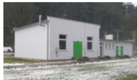
čerpací stanice Pod Horou po rekonstrukci
