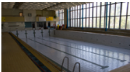
KBP bazén před rekonstrukcí
