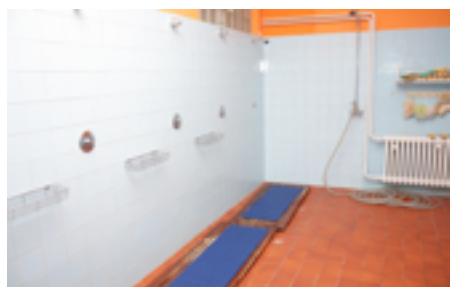
Sauna 2012 sprchy před konstrukcí.
