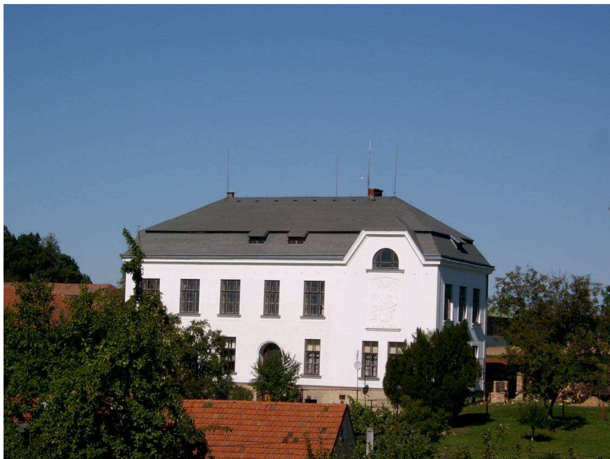
objekt bývalé školy, dnes bytový dům ve Voděradech
