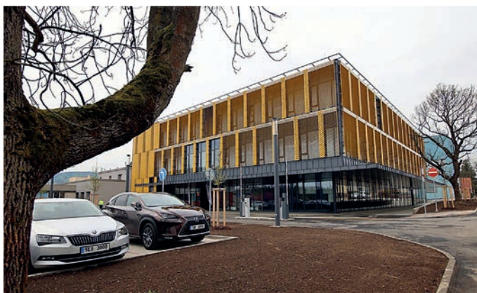
V Orlickoústecké nemocnici byl v květnu otevřen nový urgentní příjem, čtyřpodlažní objekt centralizuje urgentní akutní péči.
