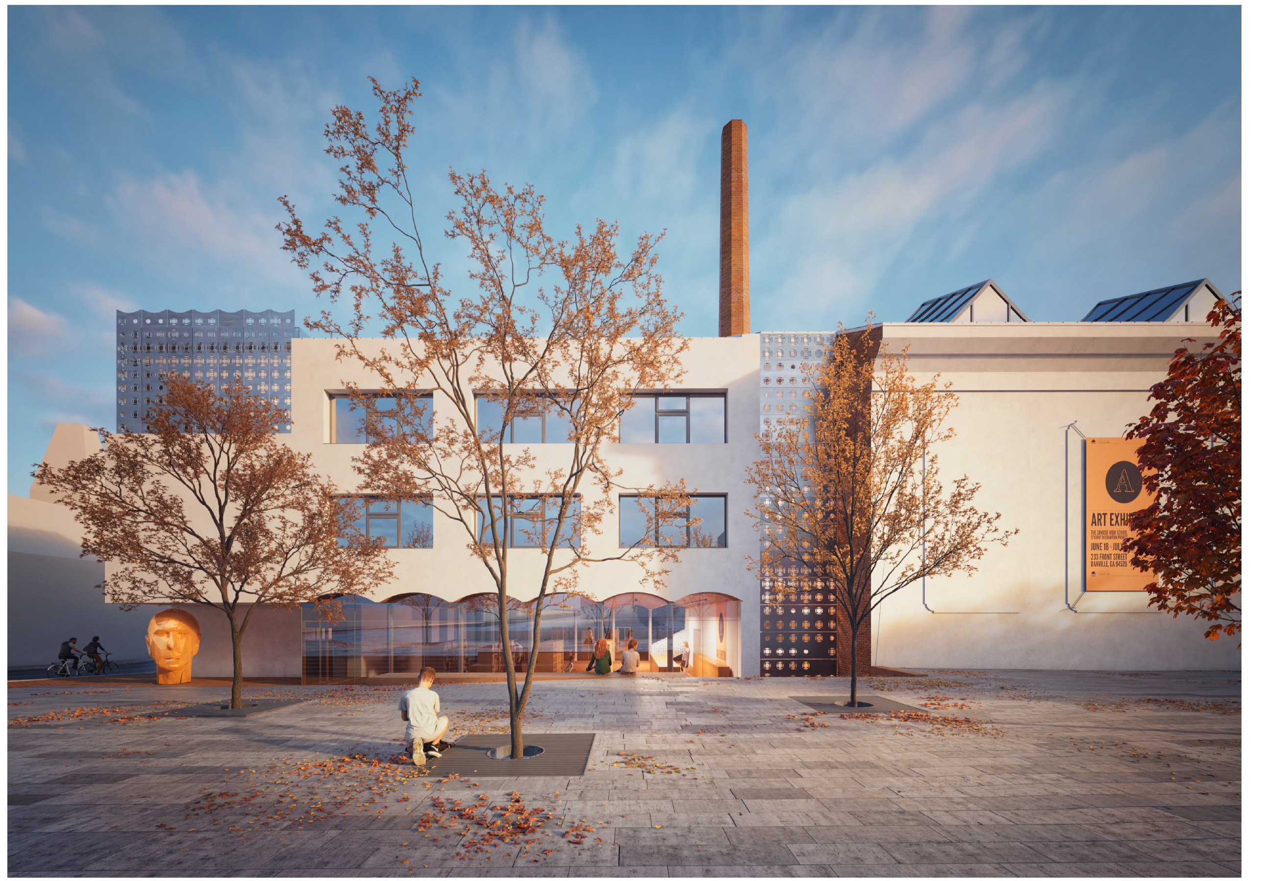
POHLED NA HLAVNÍ VSTUP Z NÁMĚSTÍ
