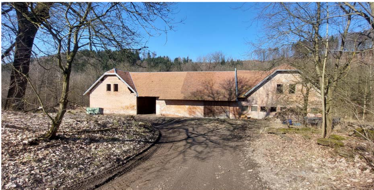
Fotografie březen 2026 - Pohled od jihovýchodu, vlevo průjezd usedlostí
