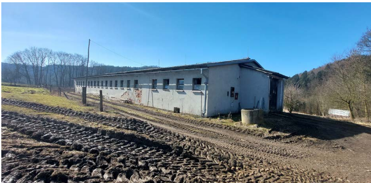
Fotografie březen 2026 - Stáj firmy Avena s hovězím dobyt看, od dvora cca 45 m.
